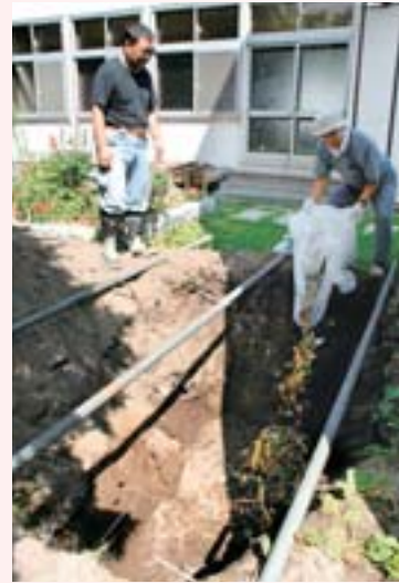
上) 札幌サンプラザ前の特設ステージ 中) ごみ分別の手助けをするスタッフ 下) 生ごみは深さ1.5メートルの穴へ
