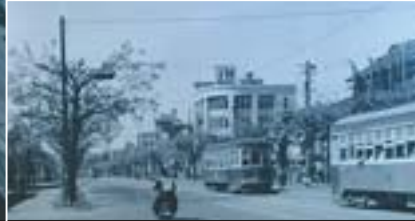
昭和27年。北1西3から北側を望む。側道の様子が分かる
