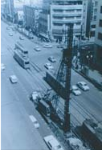
地下鉄工事中の昭和44年。北1西3付近
