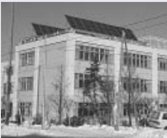
美しが丘小学校の屋上に設置された二基の「太陽光パネル」
