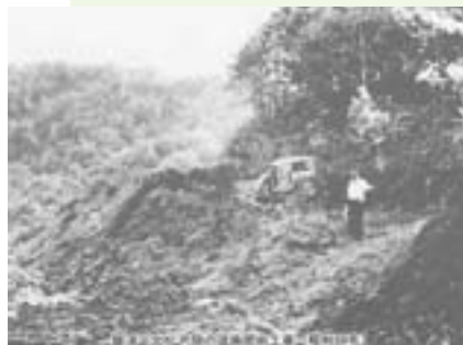
▲道路開削工事の様子(昭和38年)
