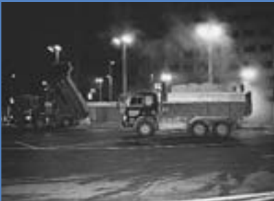
都心部エリアの雪を処理する都心北融雪槽
