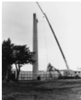
クレーン車による解体作業の様子
