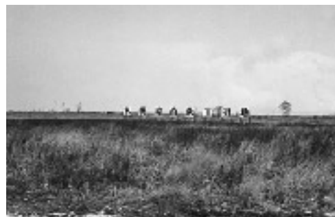
▲工場建設前の発寒鉄工団地造成予定地 現在のJR発寒駅方面から団地方面を望む
