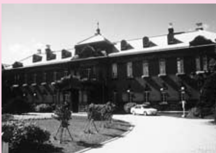
▲札幌市資料館(旧札幌控訴院。中央区大通西13)
