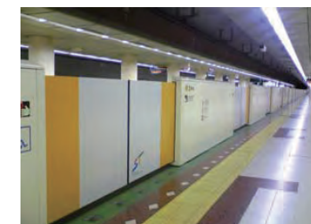
地下鉄ホーム柵
