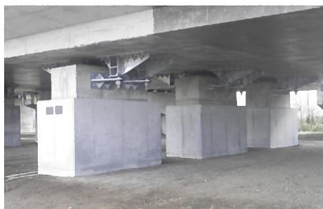
橋りょうの耐震化（橋脚補強等）
