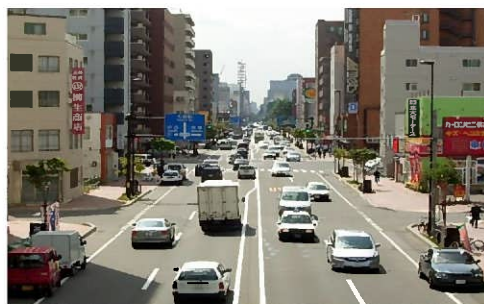
無電柱化の推進（西5丁目・樽川通）
