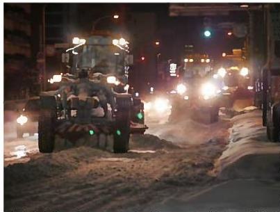
幹線道路の除雪の様子
