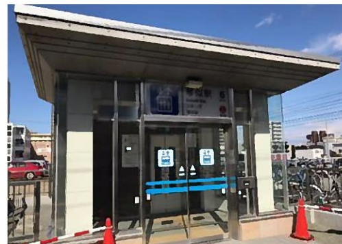
エレベーターの増設（地下鉄琴似駅）
