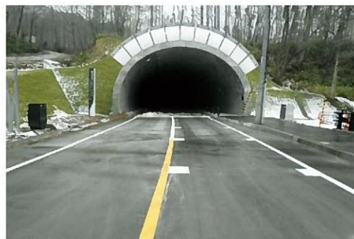
盤溪北ノ沢トンネルの開通
