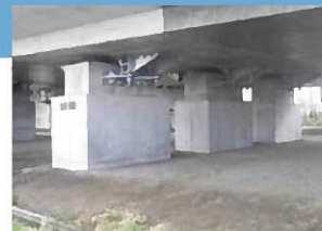
橋りょうの耐震化(橋脚補強等)
