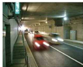
整備後のアンダーパス内の走行状況
