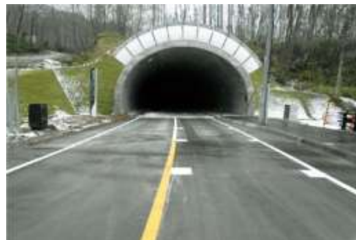
盤溪北ノ沢トンネルの開通
