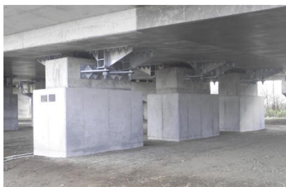
橋梁の耐震化（橋脚補強等）
