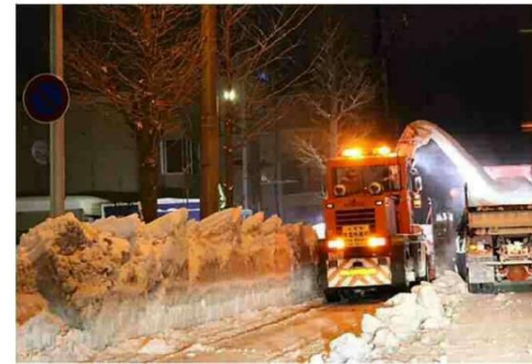
幹線道路の排雪の様子
