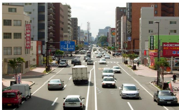
無電柱化の推進（西5丁目・樽川通）
