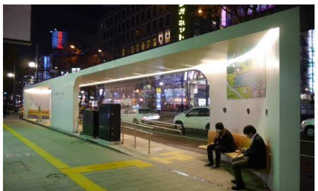
路面電車停留場
