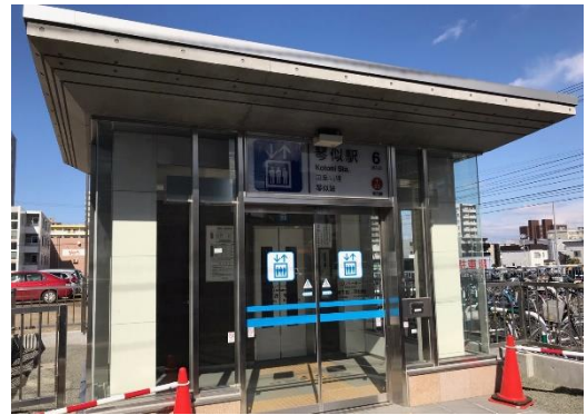
エレベーターの増設(地下鉄琴似駅)
