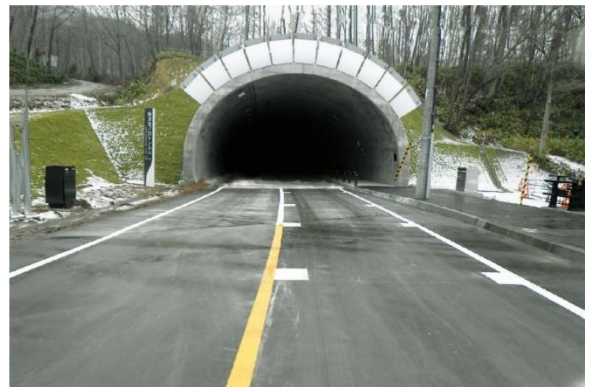
盤渓北ノ沢トンネル
