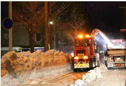
幹線道路の排雪作業の様子
