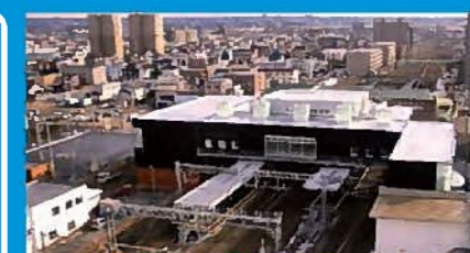
JR白石駅周辺地区整備▲
