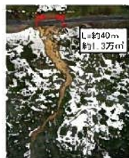
<Kp40 8土砂崩れ箇所>
