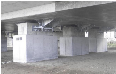
橋りょうの耐震化（橋脚補強等）
