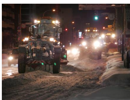
幹線道路の除雪の様子
