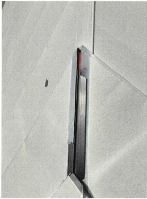
屋根金具なし(金具製作後取付する)
