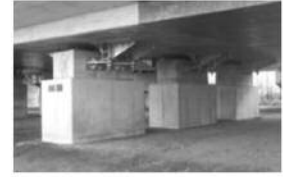
橋梁の耐震化（橋脚補強等）
