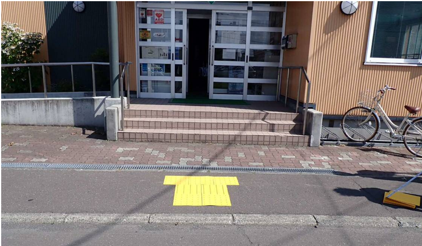
点字ブロックの設置例
