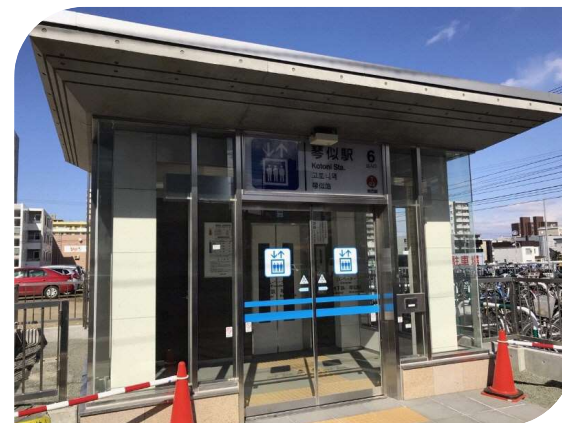
地下鉄駅エレベーターの増設
