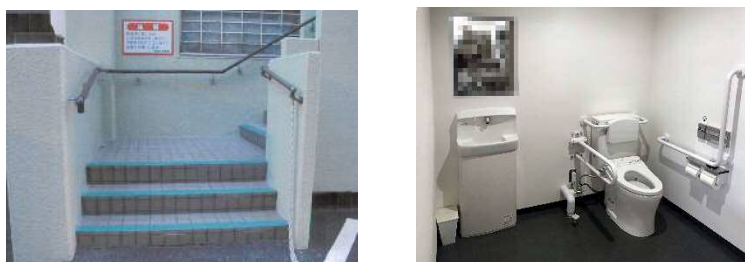
階段に手すりを設置した事例
