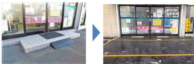
店舗入口の段差を解消した事例
