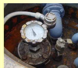
直読み式 液面指示計
