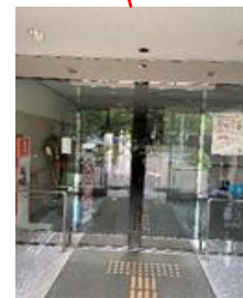
白石消防署正面玄関
