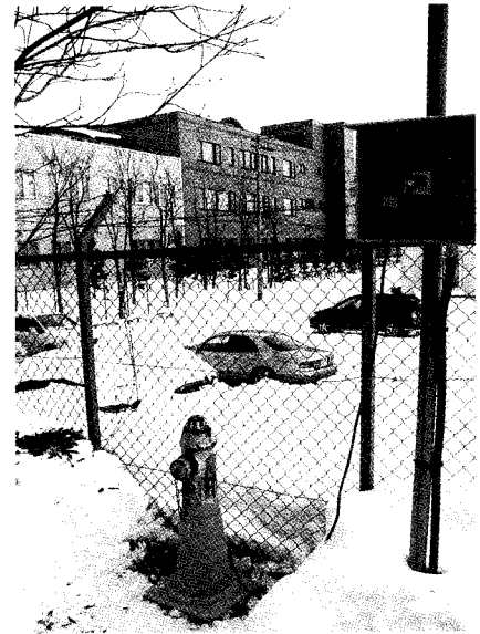
写真2 消火栓への取り付け状況
