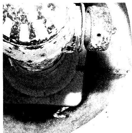
写真12 内部の熱電対状況
