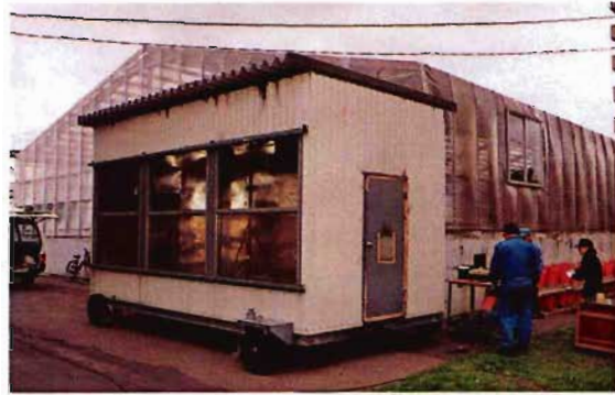
写真5 燃焼実験ハウス
