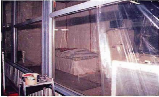
写真12 ビニールでの目張り状況
