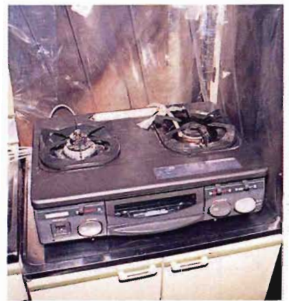
写真16 二酸化炭素放出ホース 設置状況
