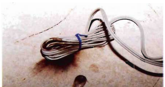
写真25 実験5電気配線短絡の状況
