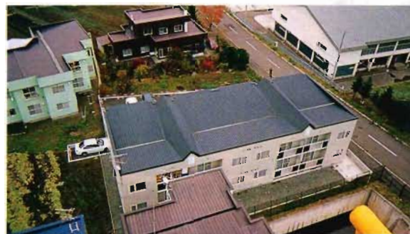
写真1 無落雪型木造共同住宅
