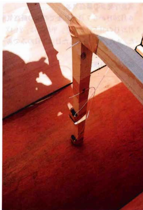
写真5 温度測定器の設置状況
