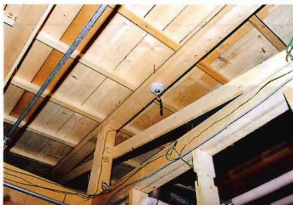
写真2 狭隘な小屋裏空間
