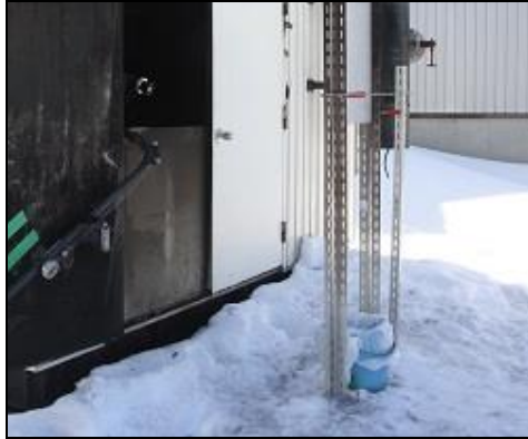
図 11 外壁材直下に設置した水採取用バケツ
