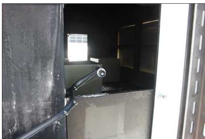
図 4 調整した排気口に設定した水力換気ノズル
