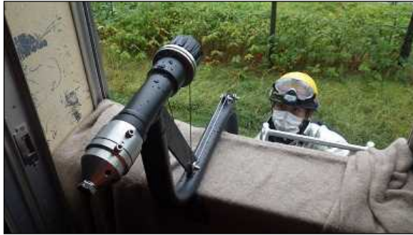
図 12 2 階窓への水力換気ノズルの設定
