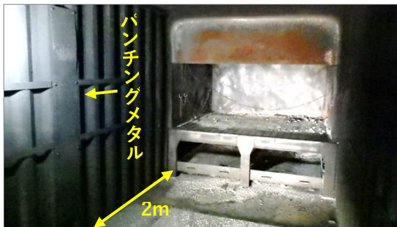
図6 装置温度計の据付状況
