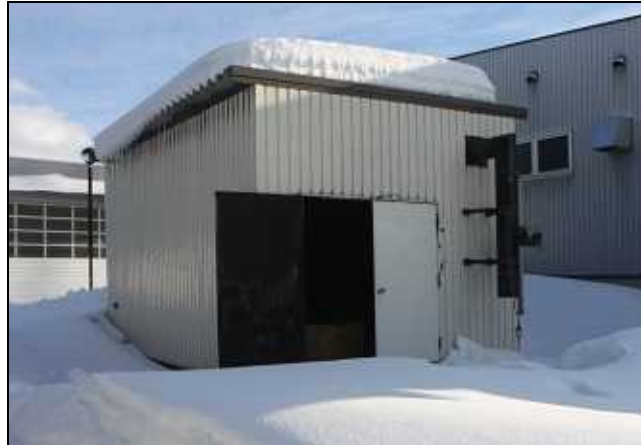
図 2 燃焼実験ユニット（北東面）
