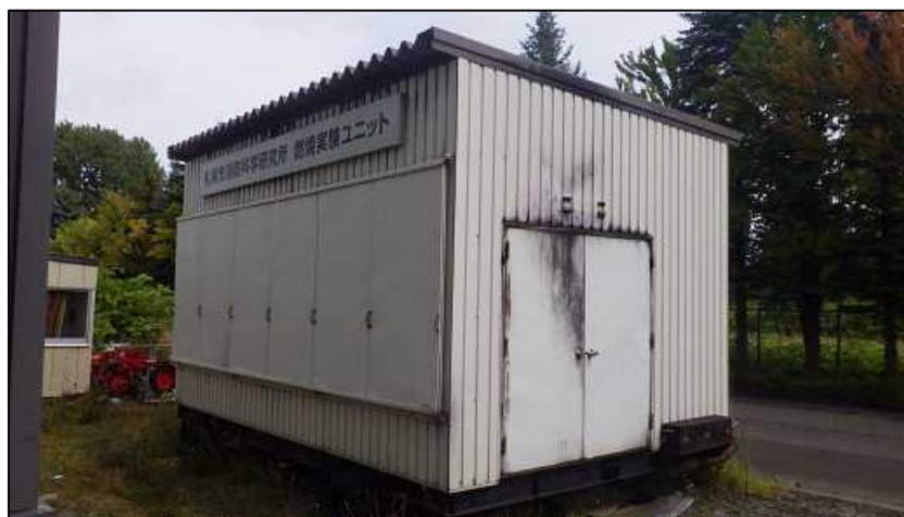
図2 燃焼実験ユニット(外観：南面及び西面)
