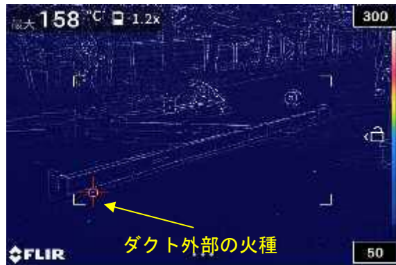
写真 120 注水から 2 分後
