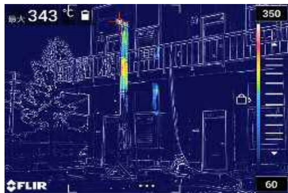
写真 14 注水から 30 秒後
