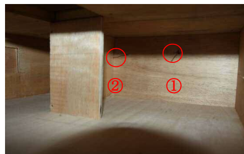
写真 18 熱電対設置状況
