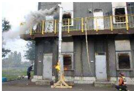
写真 9 直線ダクト燃焼状況
