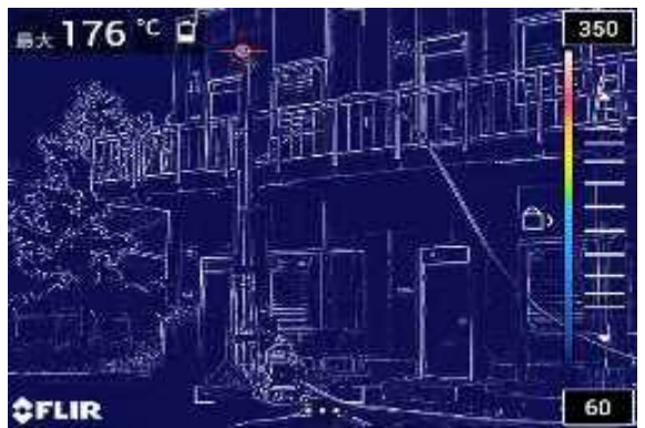
写真 41 注水から 3 分後
