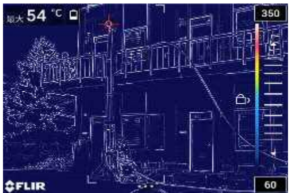
写真 45 注水から 5 分後
