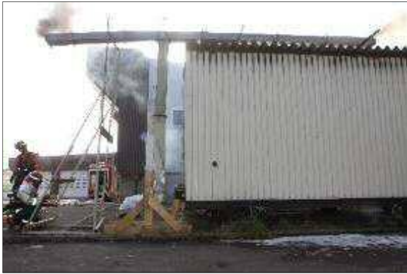
写真1 T字ダクトの燃焼状況
