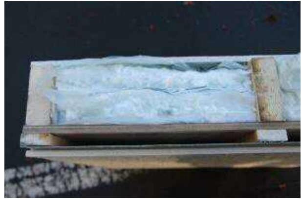
写真2 外壁模型 A (外壁側上部)
