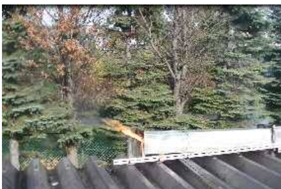
写真 84 注水から 1 分後
