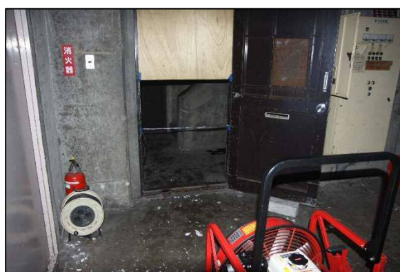
写真5 訓練本塔での検証状況（1階給気側）
