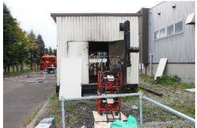
写真4 可搬式ブロアー設定状況
