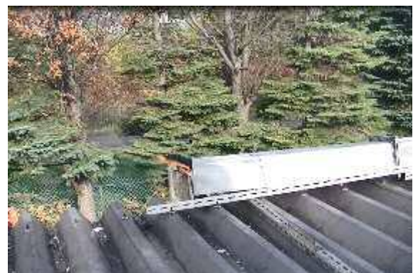
写真 85 注水から 3 分後
