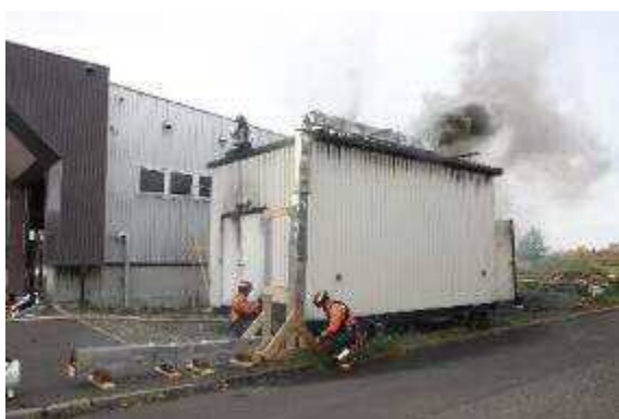
写真 10 S字ダクト燃焼状況
