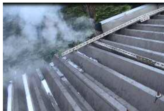
写真 115 注水から 1 分後
