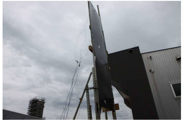
写真2 鉄板設定状況
