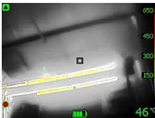
写真 40 ウォーターカッターノズル (3分30秒後)
