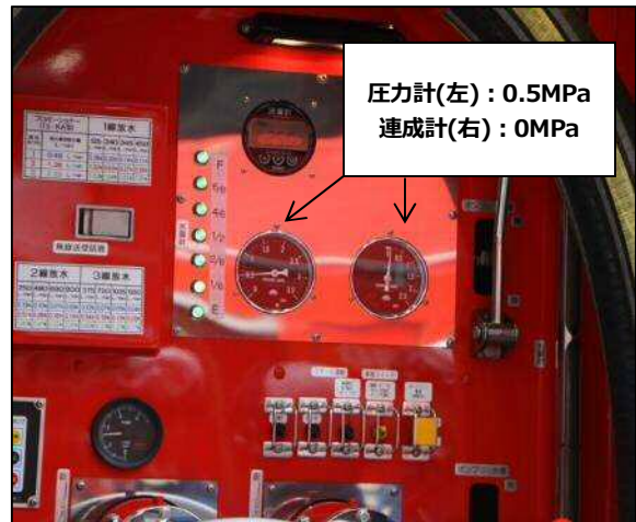
写真 3 検証 1 のポンプ操作盤状況
