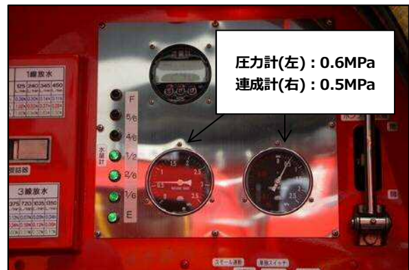
写真 7 検証 2 のポンプ操作盤状況
