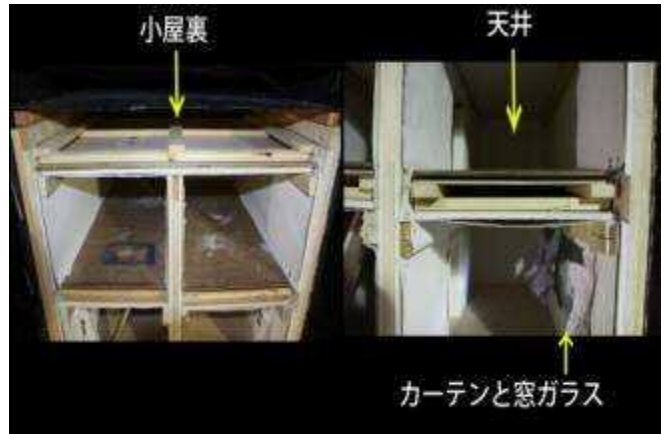
写真2 小屋裏と天井
