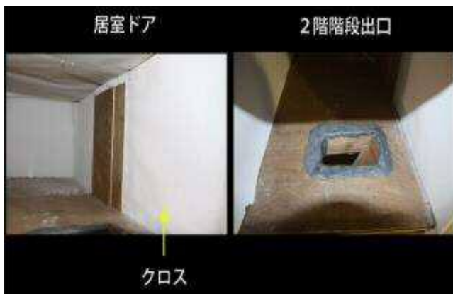
写真3 室内ドアと階段
