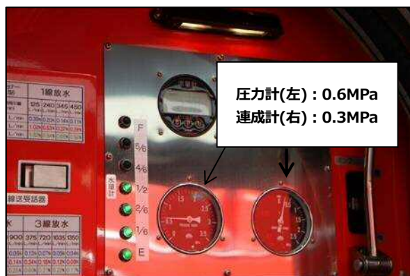
写真8 検証3のポンプ操作盤状況
