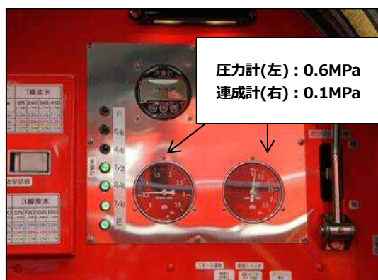
写真9 検証3のポンプ操作盤状況
