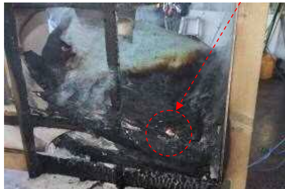
写真10 放水（1回目）直後（背面側）
