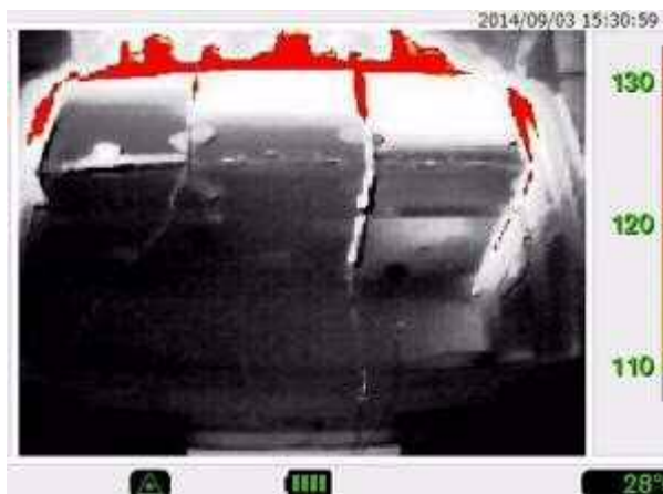
写真 22 ケイ酸カルシウムボード下面の熱画像 (実験開始 180 秒後)
