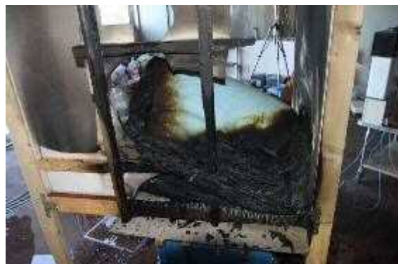
写真 12 放水（2回目）直後（背面側）
