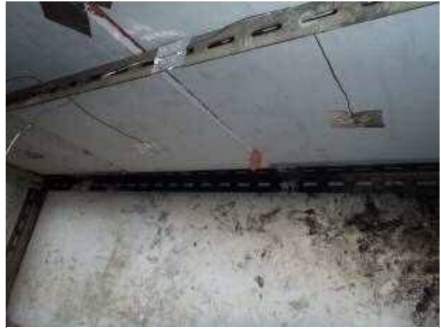
写真 9 熱電対設定状況 3 (ケイ酸カルシウムボード下面)
