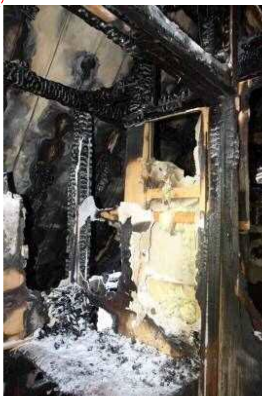
写真 67 押入れの状況 (南西側から撮影)
