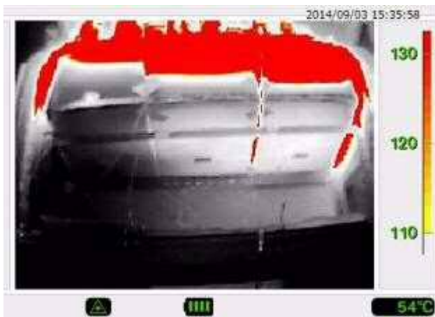
写真 2 6 ケイ酸カルシウムボード下面の熱画像（実験開始 480 秒後）
