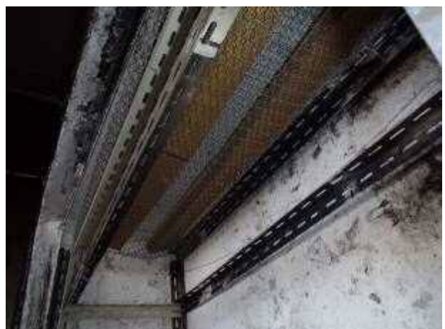
写真 13 燃焼材設定状況 2
