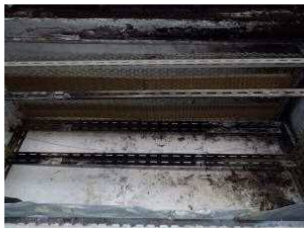
写真 12 燃焼材設定状況 1
