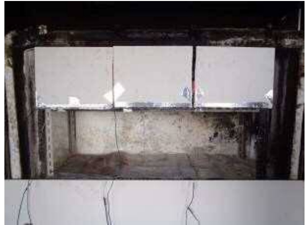
写真 1 5 グラスウール設置状況 1
