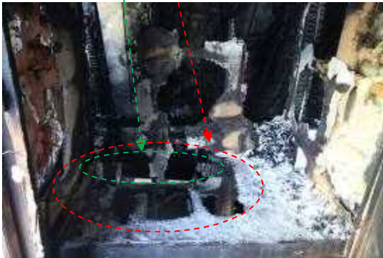
写真 68 押入れ中棚の状況 (南側上方から撮影)
