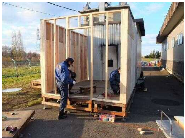
写真2 改修中の状況
