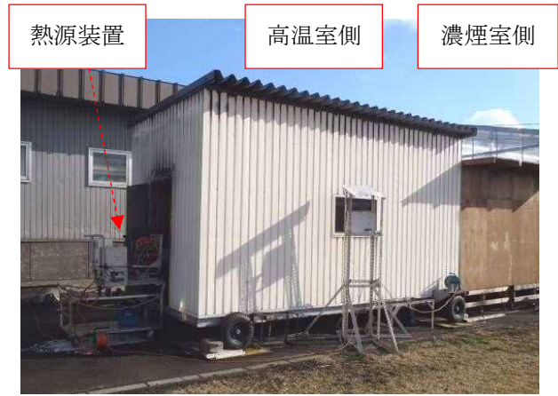
写真4 改修後の施設全景
