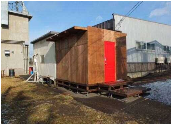
写真3 改修後の施設全景
