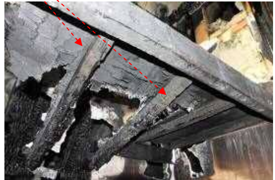
写真 69 押入れ中棚の状況 (南西側下方から撮影)
