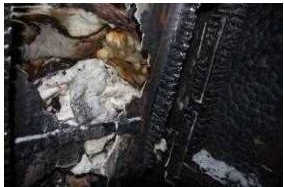
写真 77 1層目まで復元時の背面側の状況 (押入れ背面側の壁体内より北東側から撮影)
