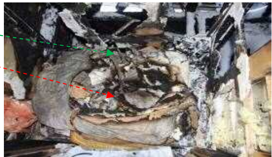
写真 74 5層目まで復元時の状況 (南側から俯瞰撮影)
