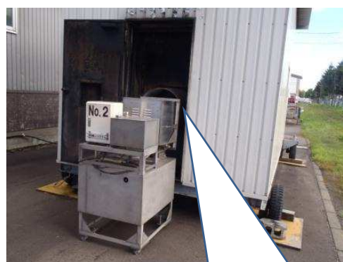
出入口を鋼板で覆いバーナー部を貫通
