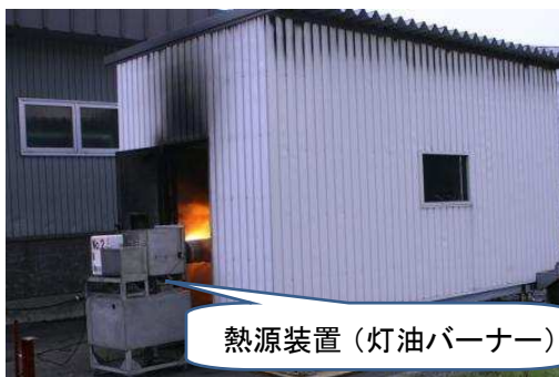
写真 No. 1 訓練ユニット（外観）
