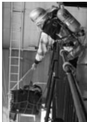
写真10 ロープによる資材引揚げ
