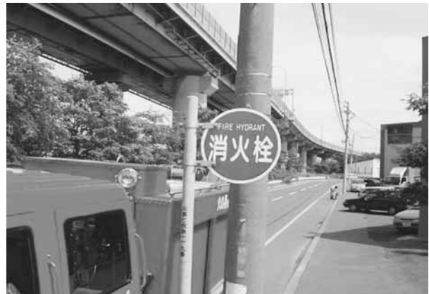
型枠を用い再塗装した標識
