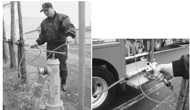
エアガンの引き金を引き排水
