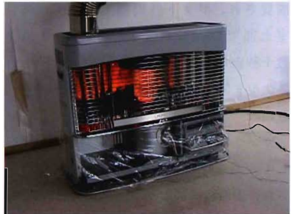
写真11 正常燃焼時の状況
