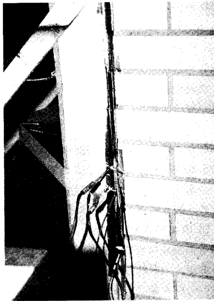
写真8 熱の拡散防止アルミテープの貼付状況
