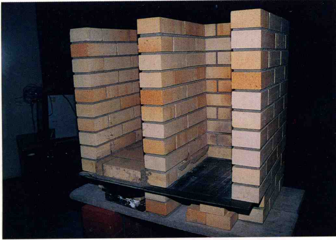
写真10 耐火煉瓦製炭焼炉（焚き口側）
