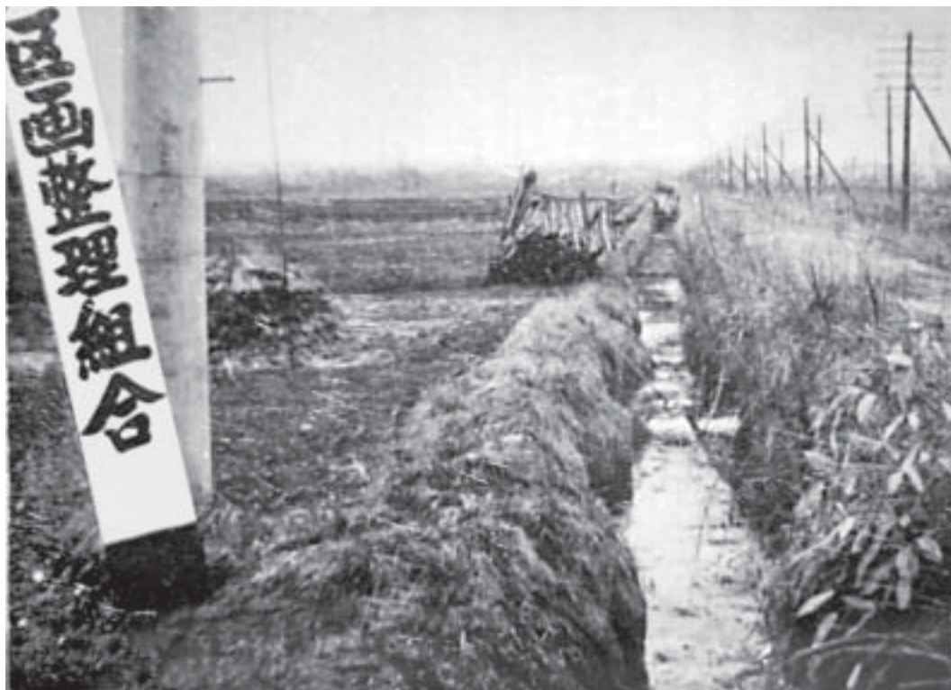
区画整理が始まった当初（北都地区会館展示板から）
