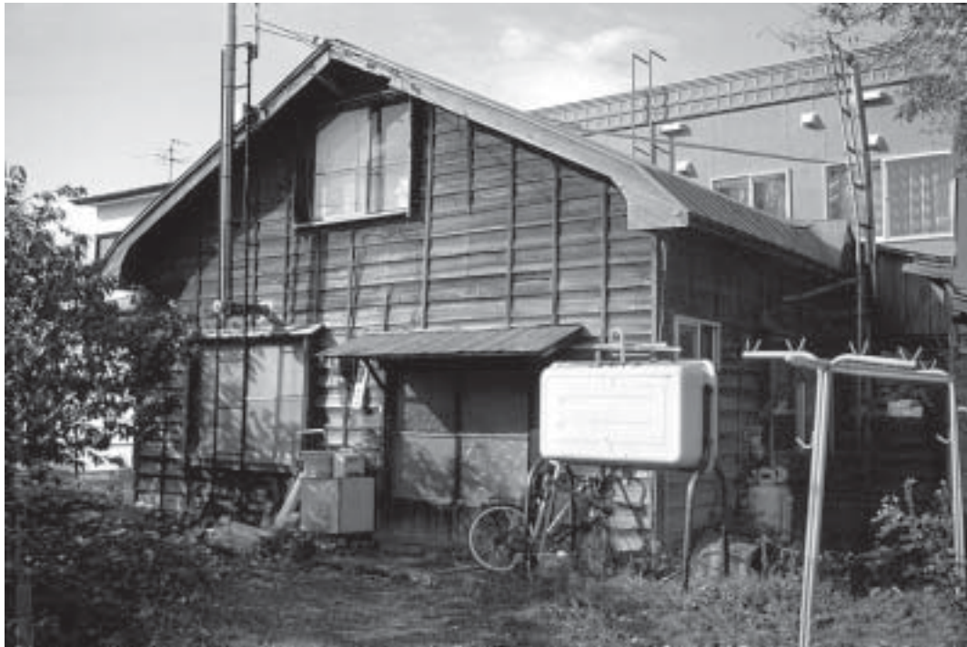
完全な状態で残っている建物は1戸だけ。後ろ半分はアパートに建て替えられている
