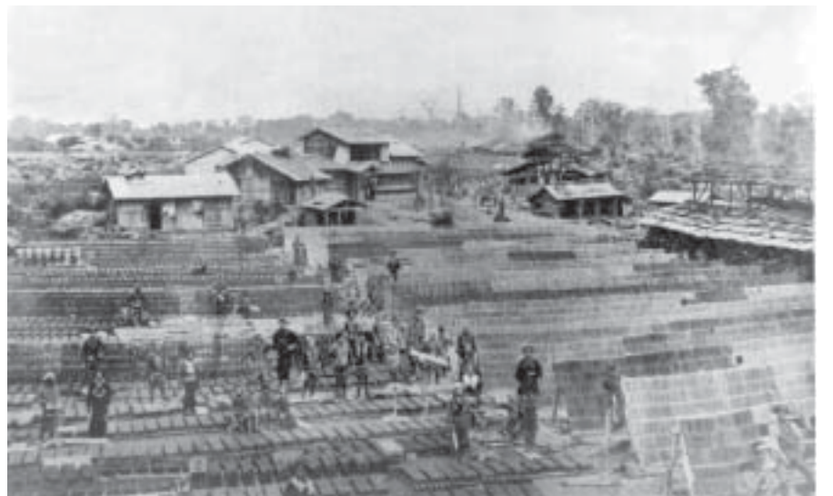
鈴木煉瓦製造場の干場(明治19年)
