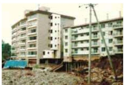
③激流に洗われ土台部分がえぐりとられ、基礎部分までが洗い流された真駒内のマンション(昭和56水害)
