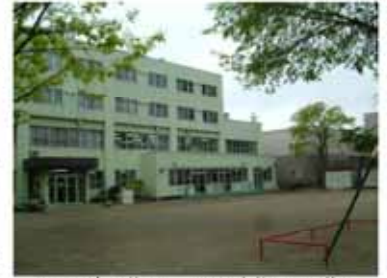
しらぎく荘は、この建物の3階と4階にあります
