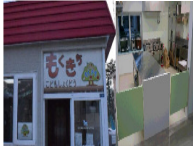
空き家をコミュニティハウスへ改修
