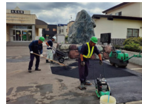
町内会館の老朽化した駐車場を無償で補修
