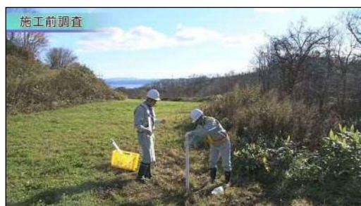
②地下水観測孔設置
