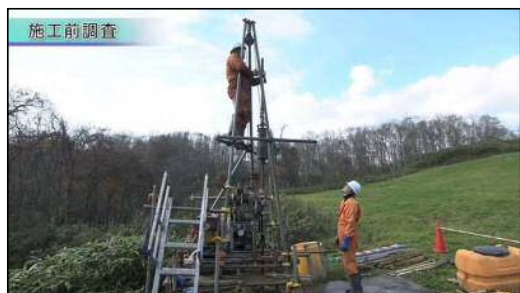
①ボーリング調査
