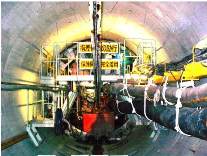
工事中のトンネルの状況
