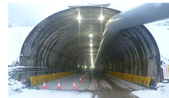
21.内浦トンネル(東川) 本坑状況
