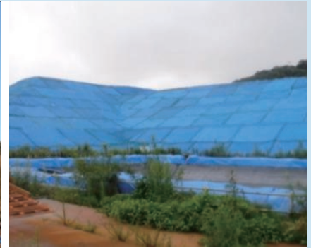
仮設シートによる養生
