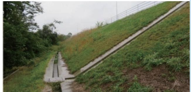
盛土斜面の整備状況の例
