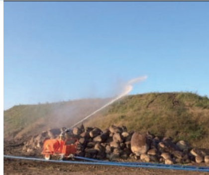
盛土への散水
