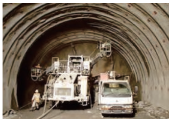
ロックボルト施工
